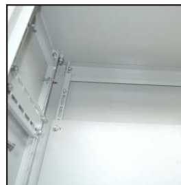
Монтажные элементы регулируются по высоте
