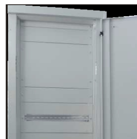
Установка фальш-панелей
